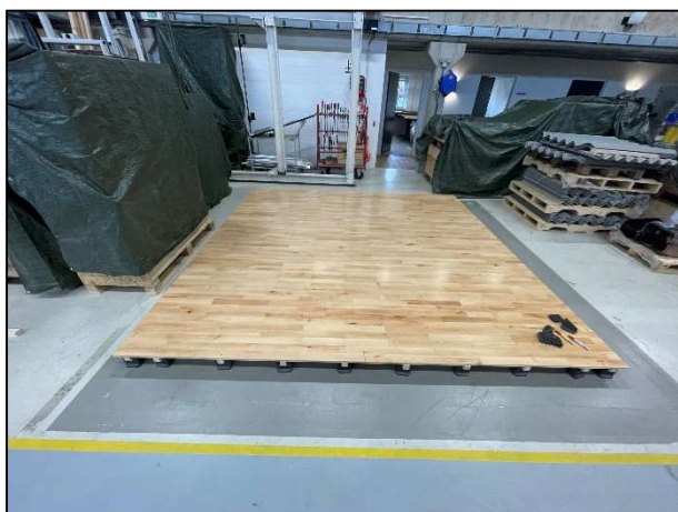
Foto 1: Test gulvkonstruktion 3,5x3,5 m
