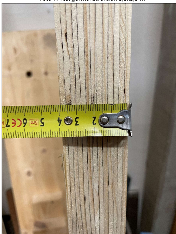
Foto 3: Benyttet strø til understøtning af gulvkonstruktion
